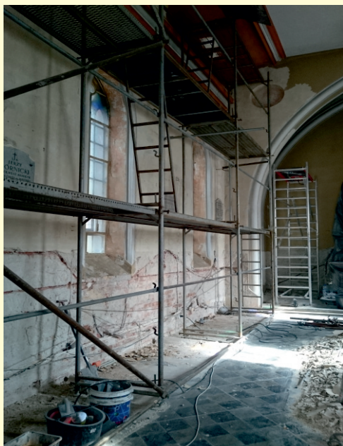
Remont kaplicy na cmentarzu 2015 r.
