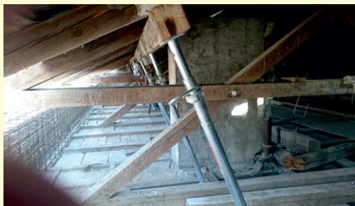
Remont dachu na domu parafialnym
