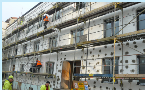
Termomodernizacja – prace remontowe budynków parafialnych przy ul. Kazimierza Wielkiego 5 i 7 – 16.12.2019
